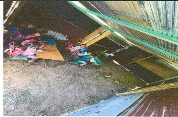
Foto 4: Piso de cemento interior de aulas.
