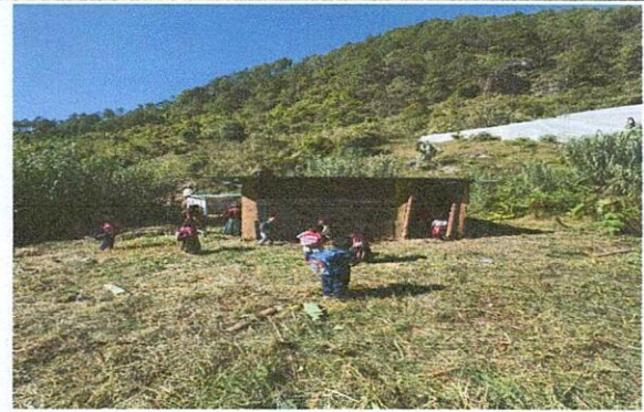
Foto 2: Instalación de puertas metalicas.
